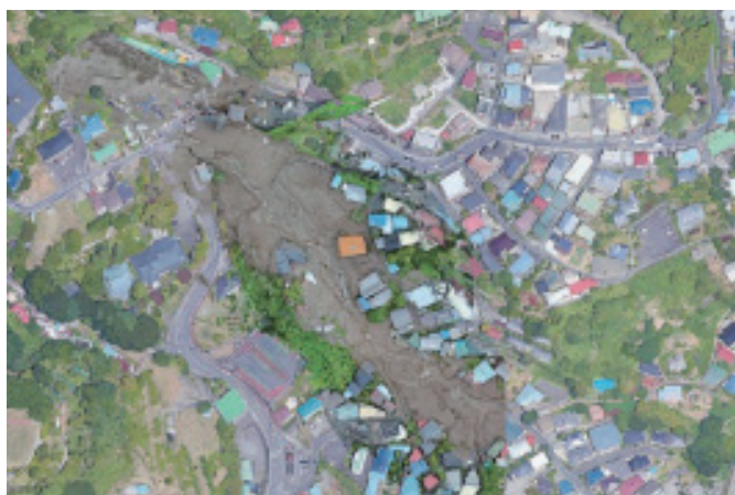
静岡県熱海市の被害状況
