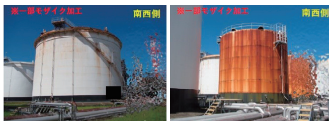
図2-1 （左）浮き屋根を有する屋外貯蔵タンク外観 （右）浮き蓋付きの屋外貯蔵タンク外観
